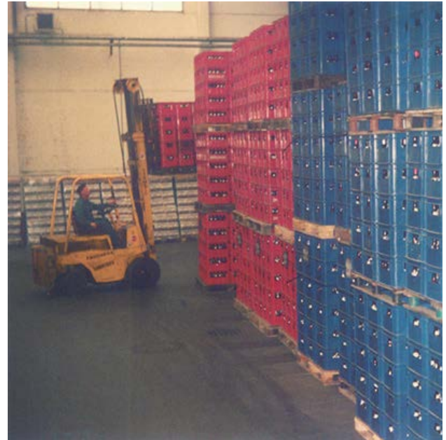
Vue du hall de stockage de la Brasserie de Diekirch en 1974. On se rend compte que les casiers bleus ne portent pas encore l'inscription blanche DIEKIRCH.
