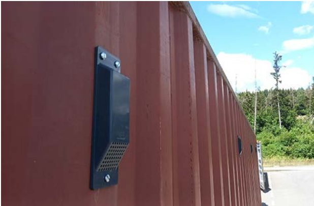
10 bouches d'aération par container assurent une circulation d'air à l'intérieur.
