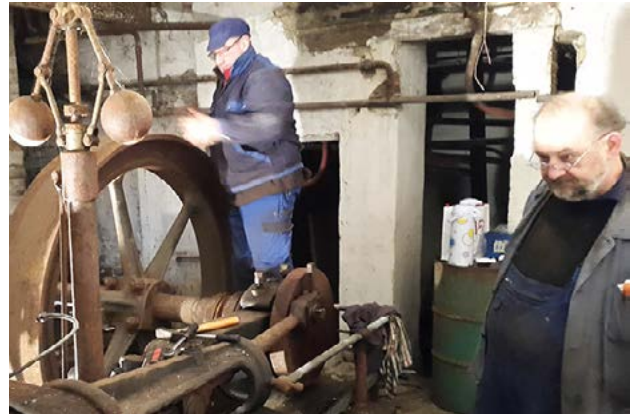
Arsène Pennartz und Marco Reckinger beim Abbau einer Dampfmaschine im November 2015
