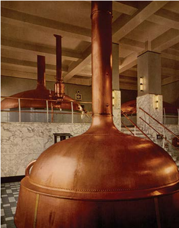
La salle de brassage de style Bauhaus, photographiée dans les années 1960. Hormis l'éclairage, rien n'a optiquement changé dans cette pièce, seulement des armoires, un bureau et une nouvelle station de commande informatique ont été ajoutés.
