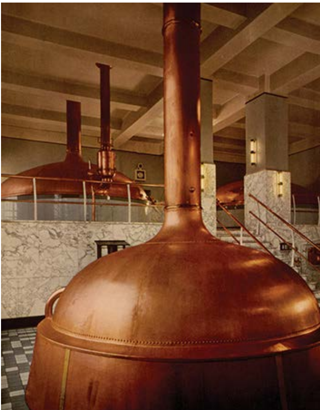
Der Brauraum, im architektonischen Bauhaus-Stil; fotografiert in den 1960er Jahren. Bis auf die Beleuchtung wurde der Raum optisch nicht verändert. Nur einige Schränke, ein Schreibtisch und eine elektronische Schaltzentrale wurden hinzugefügt.
