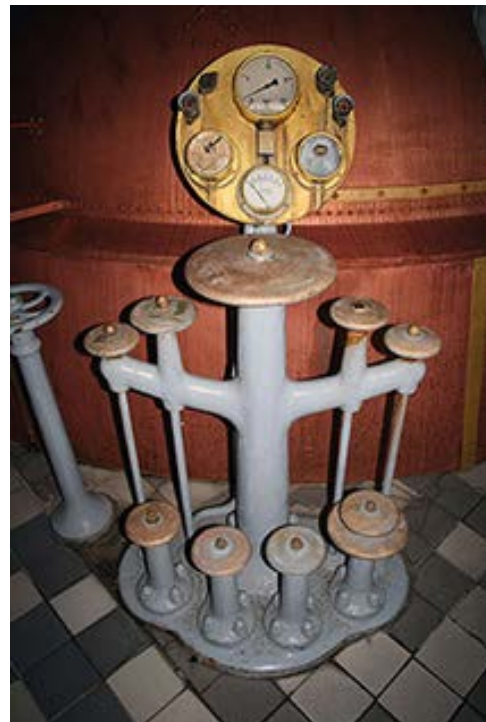
Die Originalschaltzentrale befindet sich noch vor Ort: wird sie bei der Alteisensammlung entsorgt?
