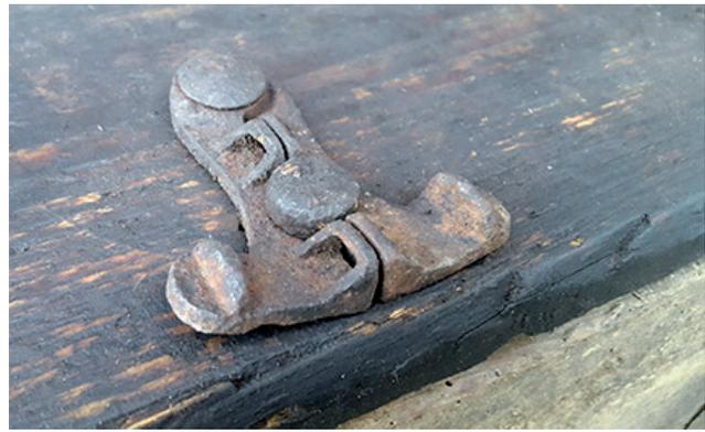
Die beiden Öffnungen des Verschlusses ermöglichten das Durchstreifen einer Schnur oder eines Drahtes mit Verplombung, um eventuellem Diebstahl während des Transportes vorzubeugen. Unser Dank geht an die Arbeitsgruppe des Nationalen Militärgeschichtsmuseums, welche das Vertilgen des Ungeziefers übernahm.
