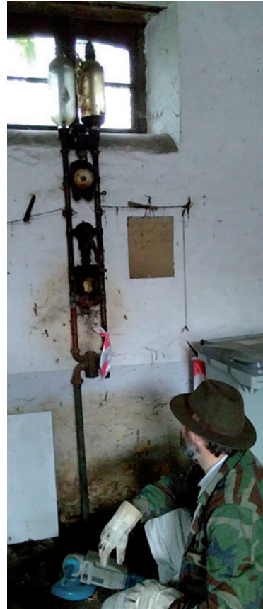
Demontage der Benzinpumpe aus der LKW-Garage der Brauerei in Mellier.
