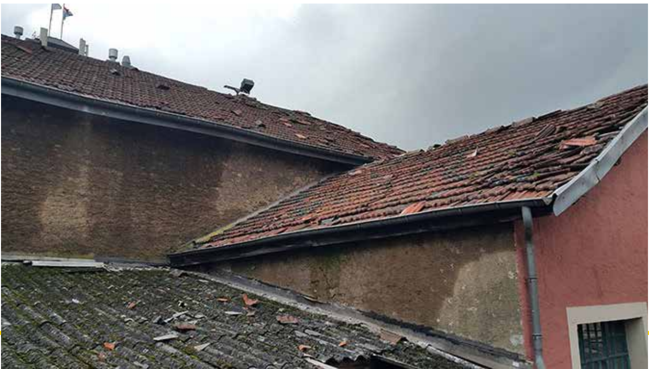
Plus de 20 mètres carrés de tuiles ont été soufflées de la toiture de l'ancienne écurie.
