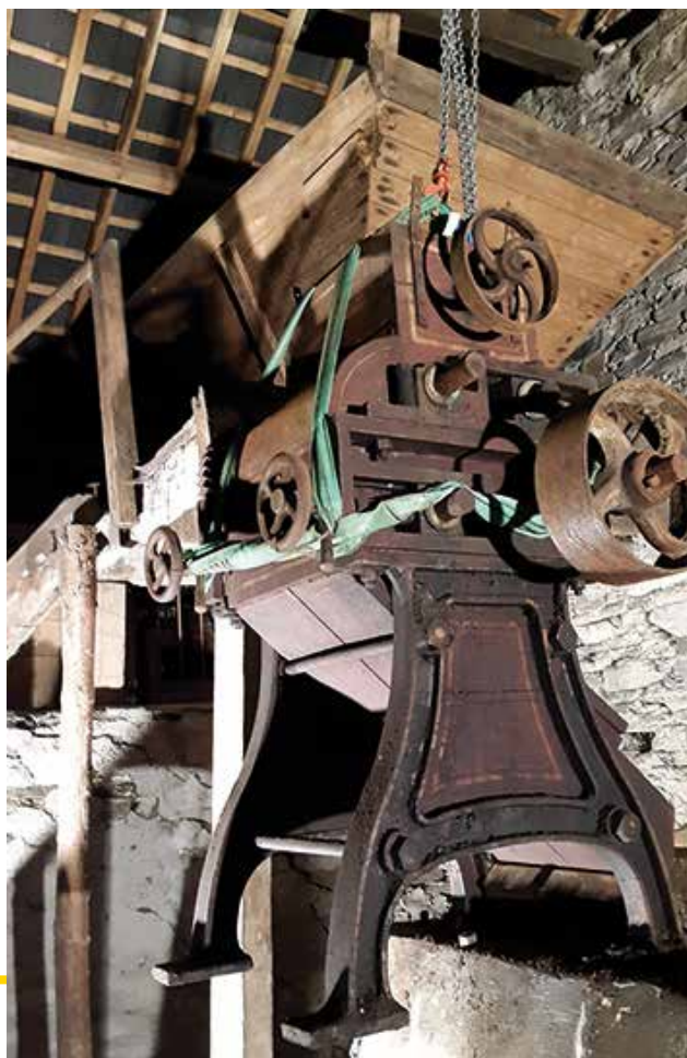
Unten: Abbau der Malzmühle im Juli 2015.
