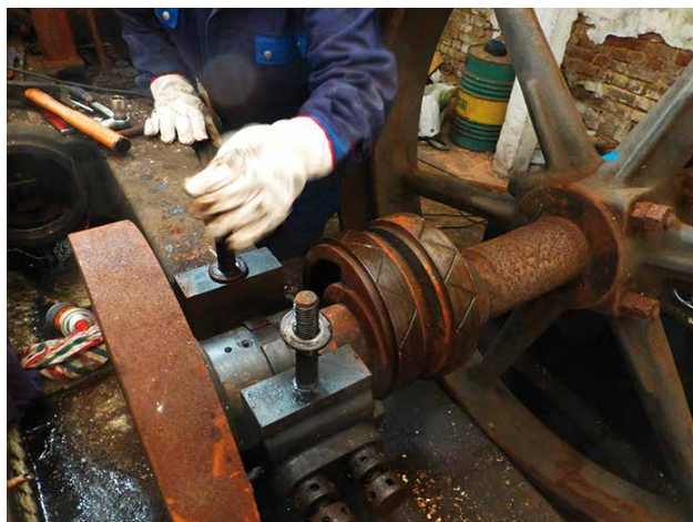
Oben: Abbau beweglicher Teile der Dampfmaschine im November 2015.
