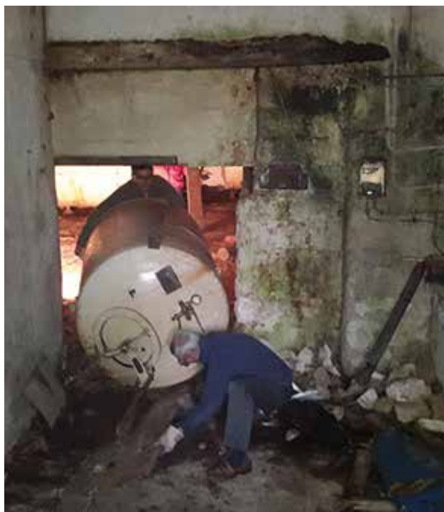
Unten: Abtransport von zwei Gärtanks der Marke Meura im Oktober 2015.
