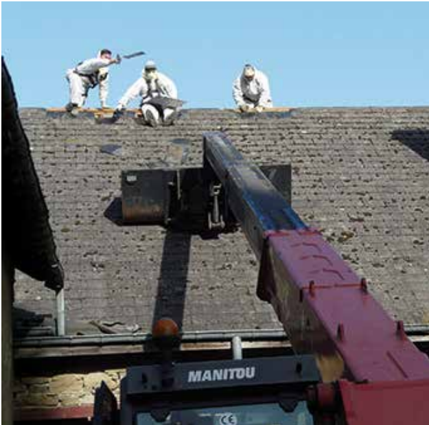
Abdecken des Eternit-Daches am 25. März 2017.
