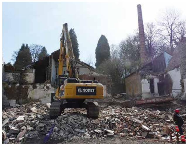
Der gesamte Braubereich wurde binnen 2 Tagen abgerissen.
