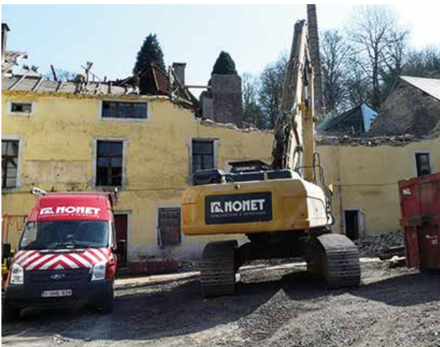
Beginn der Abrissarbeiten am 29. März 2017.
