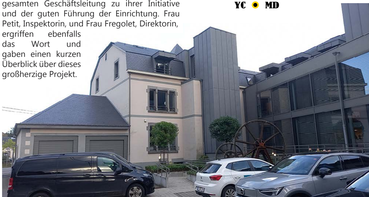
Die Räumlichkeiten des Vereins befinden sich auf dem Gelände der ehemaligen Brauerei Pierrard in Mellier.
