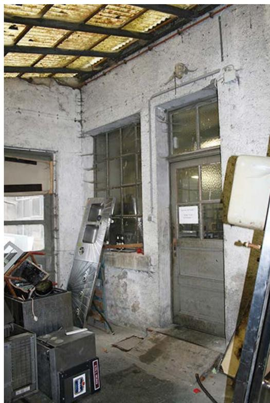
Oben links: die Werkstatt der Monteure in der Zuckerfabrik. Wie man sehen kann, ist die Decke aus gegossenem Beton, also nicht brennbar.
